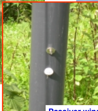
Passiver windbetriebener Rohrentlüfter mit Probenahmestutzen
