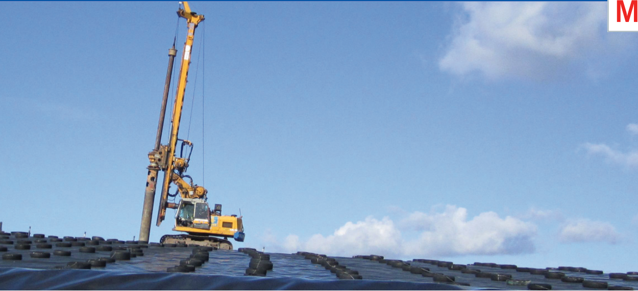
Bild 1: Gasbrunnenbohrung in einen Deponiekörper. Durch die entstehenden Zugänge wird Luft zugeführt und mit Deponiegas beladene Abluft abgeführt.
