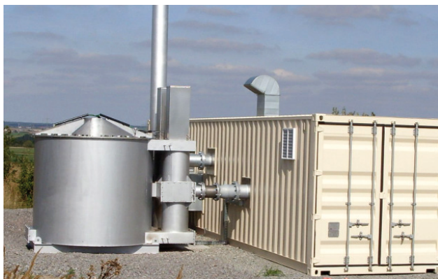
Bild 2: Die aus der Deponie abgezogene Abluft wird mit einer Regenerativen Thermischen Oxidationsanlage (RTO) gereinigt.
